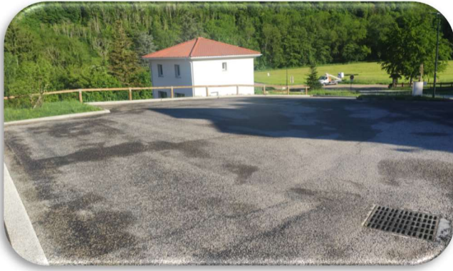
Parking de Pommiers (2023) 37 000 €/5 000 € de subventions et 6 000 € de FCTVA
