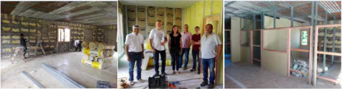
Réunion de chantier hebdomadaire avec l'architecte Lucie COTTON, les entrepreneurs ainsi qu'Albin Ribeiro (Zéme adjoint)
